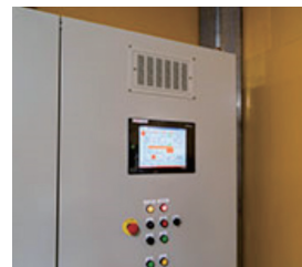
タッチパネル式制御盤
