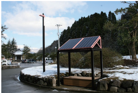
昼間:太陽電池により発電しEDLCに蓄電
