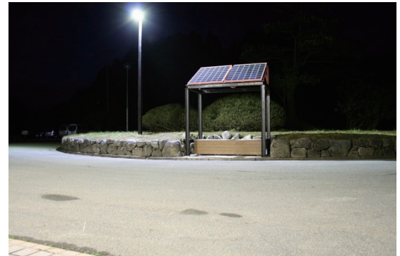
夜間:EDLCに蓄電したエネルギーを使用し照明点灯
