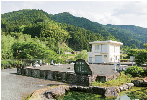
土佐町 水道施設
