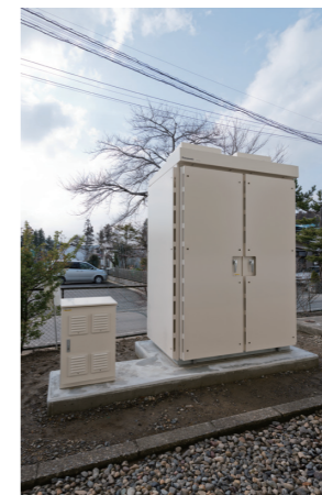
野田村役場に設置された大型リチウムイオン蓄電池。
