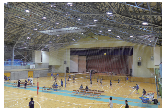
公式試合も行える野田村体育館に設置されたLED照明器具。
